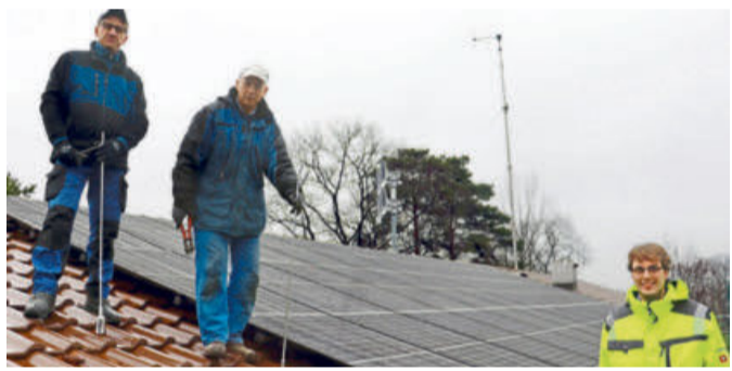
Alexander Peters und Florin Vescariu-Paal von der Firma Mauerer bei der Installation des Blitzschutzes sowie Klimaschutzmanagers Moritz Pucker (von links). Foto: Gemeinde Hövelhof
