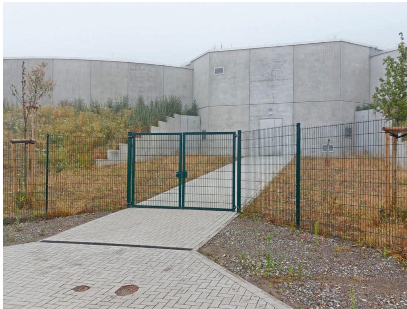
In den beiden Kammern des neuen Hochbehälters in Bergkirchen können bis zu 10.000 Kubikmeter Trinkwasser gespeichert werden. Zusammen mit dem altern Behälter nebenan ergibt sich ein Gesamtvolumen von etwa 17.000 Kubikmetern. Fotos: Malte Samtenschnieder
