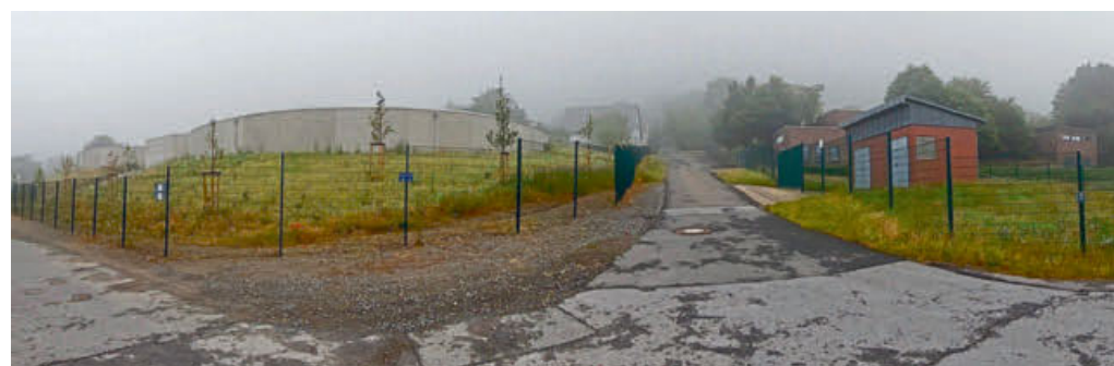
Ungewöhnliche Perspektive: Auf diesem Panoramabild ist links der neue Hochbehälter in Bergkirchen mit seinen zwei Kammern und rechts die alte Anlage zu sehen. Der Pegelstand ist durchgängig gleich.
